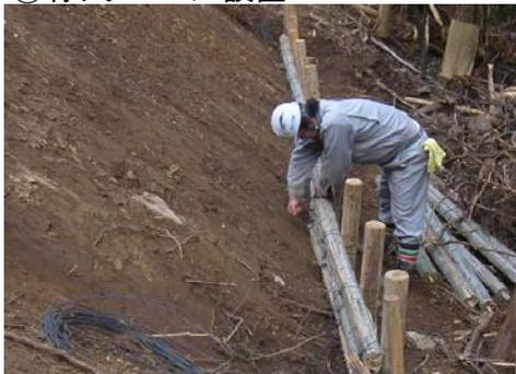
竹ソダロールの設置に当たっては、屈曲点を除いて継ぎ目が1カ所に集中しないように、各段ごとに位置をずらして配置してください。
