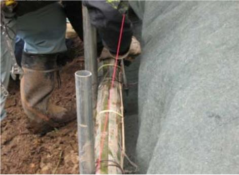
竹ソダロールと杭のすべての交点で確実に緊結してください。
